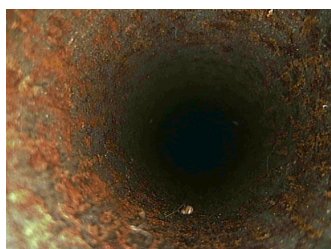
Slika 4.11 - Videoskopski snimak unutrašnjosti vodovodne cevi
