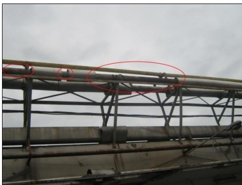
Slika 7. Oštećena izolacija
