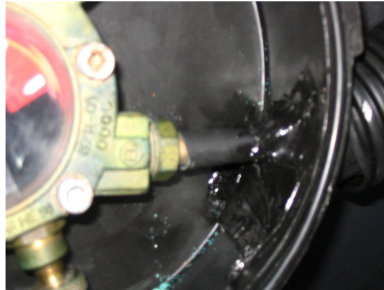
Slika 2 - Prolaz za ventilaciju zatvoren
